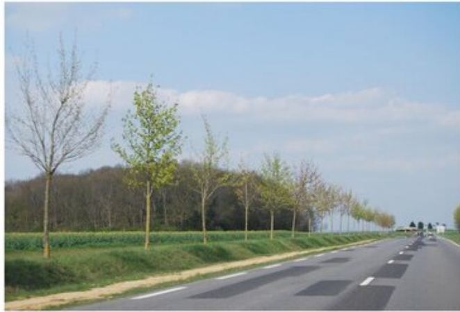
Cette replantation de la RD 134 est judicieusement réalisée derrière un talus enherbé protecteur, ce qui évite l'utilisation de glissières standardisées.
